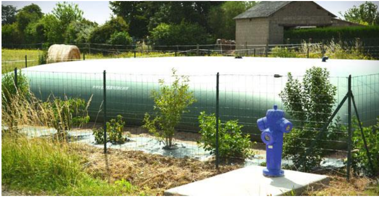
Citerne souple de 120 m³ équipée d'un Poteau d'Aspiration DN 100
